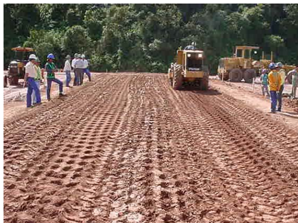
Figura 7 – Compactação da camada de solo-bentonita – Obra: Camargo Solvay. Fonte: GOUVEIA – 2005.
