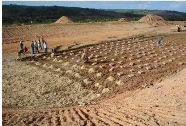
Figura 5 - Mistura manual do solo e da bentonita – Obra: Serquip. Fonte: GOUVEIA – 2005.
