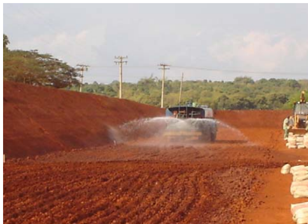
Figura 6 – Adição de água na mistura solo-bentonita – Obra: Galvani. Fonte: GOUVEIA – 2005.
