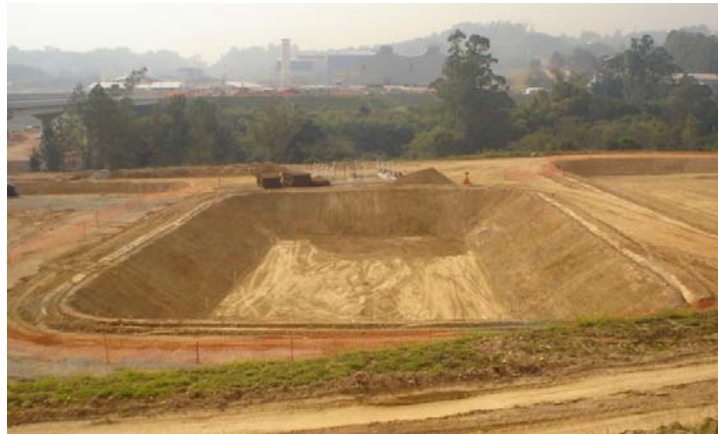
Figura 8 – Camada impermeabilizante de solo-bentonita finalizada – Obra: Camargo Solvay. Fonte: GOUVEIA – 2005.
