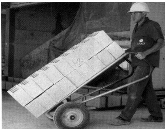
**Figura 2:** Equipamento de transporte de blocos de concreto (Fonte: CIOCCHI, 2003)
