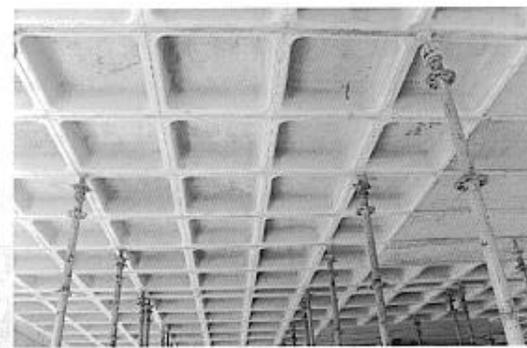
Figura - Laje Atex - (Engenharia e Construção – novembro/2002)
