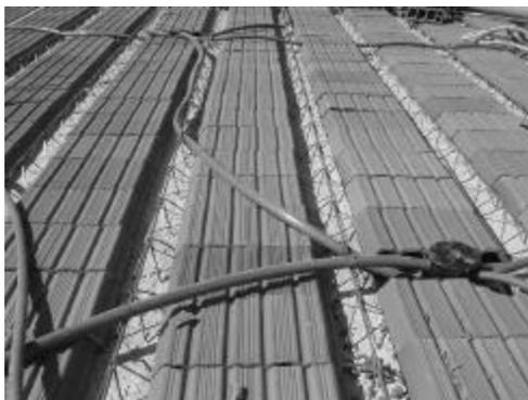
Figura 02: Laje nervurada treliçada com sapata inferior de concreto
