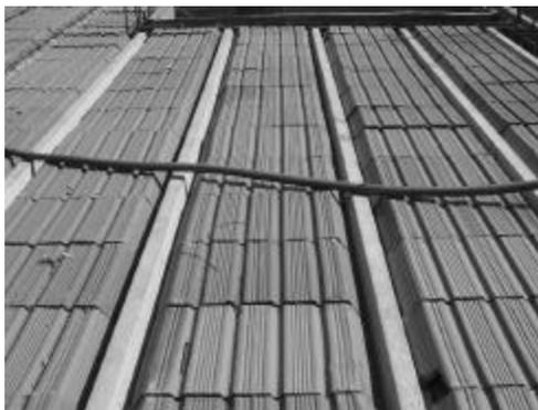
**Figura 01:** Laje pré-moldada comum
