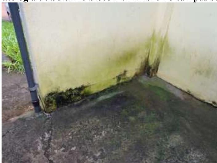
**Figura 2: Mofo na parede externa do Bloco Almoxarifado no campus sede da UEM**
