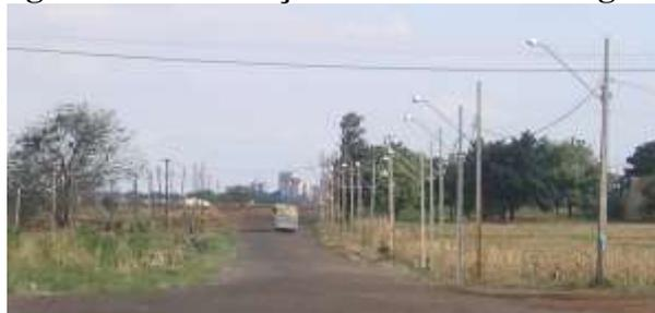
Observa-se que a avenida de acesso ao loteamento possui ponto de luz de 8 metros para suporte tipo BR-2 (Figura 3), e a disposição das luminárias são enquadradas em arranjo bilateral, conforme indica a norma, embora só esteja executada uma lateral da iluminação, devido a futuras modificações na lateral da via.
